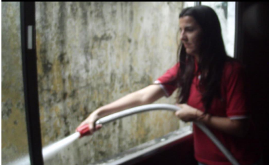
Foto 12 – Facilidade na operação e controle do mangotinho
