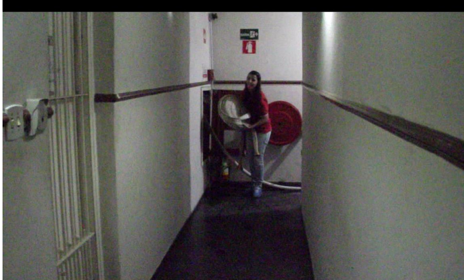
Foto 10 – Dificuldade para manuseio e lançamento da mangueira de 30m
