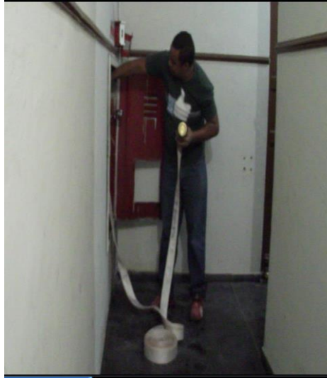
Foto 13 – Pressurização de mangueira enrolada
