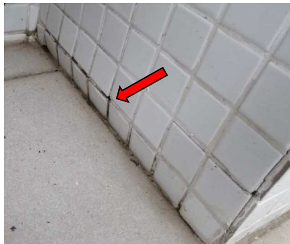
Figura 26: Trincas nas alvenarias (a) e estufamento com descolamento das pastilhas (b).
