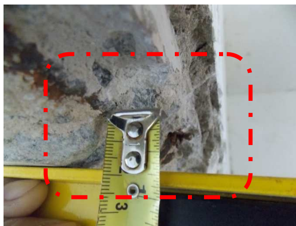
Figura 44: Armadura exposta no fundo da viga, sendo: (a) o aspecto geral da viga de concreto armado e (b) o detalhe da medição, que mostra 19mm de cobrimento no aço.
