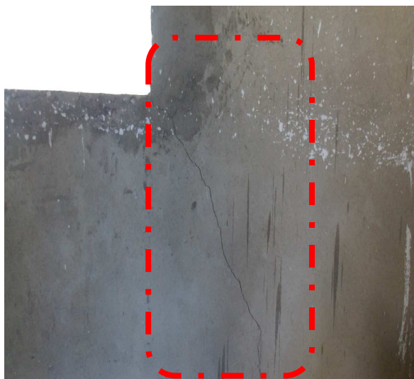
Figura 40: Fissura com 1mm de abertura, sendo: (a) aspecto geral da alvenaria com fissuras e (b) detalhe de medição da abertura da fissura em campo.
