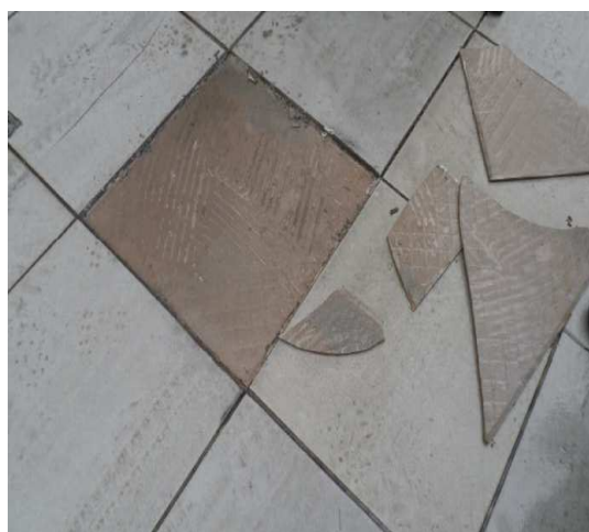
Figura 35: Não houve contato da argamassa de assentamento e o tardo, causado a quebra.
