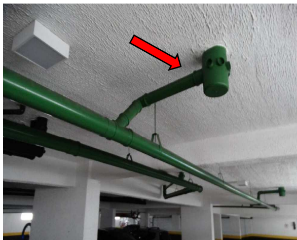
Figura 28: Ausência de suportes para fixar a caixa sifonada (a) e tubulação hidráulica sem pintura e registros sem identificação (b).
