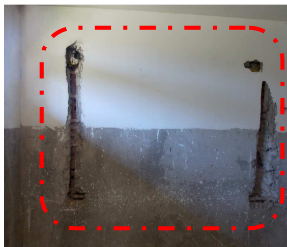
Figura 46: Ausência das instalações hidráulicas e hidrossanitárias (a) e (b).
