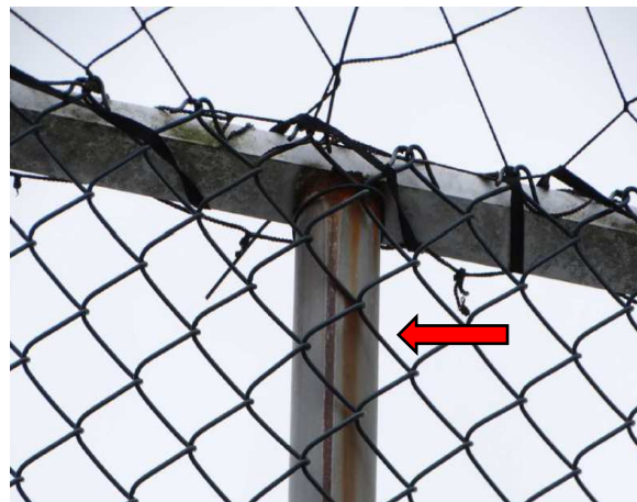
Figura 21: Revestimento com marcas de ferrugem (a) e oxidação galvânica na estrutura do alambrado (b).
