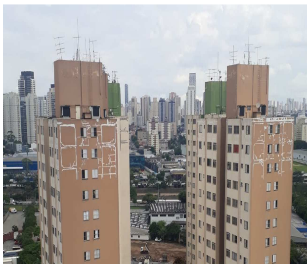
Figura 8: Fissura geométrica.
