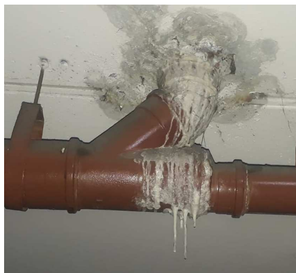
Figura 14: Lixiviação, eflorescência e formação de estalactite.
