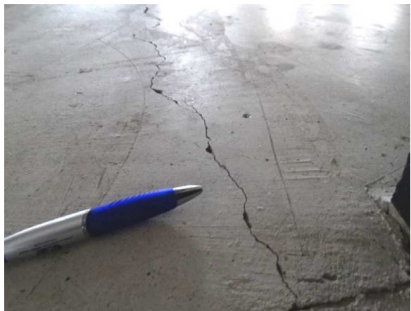
Figura 34: Fissura, trinca, buraco e argamassa pulverulenta no piso da garagem.
