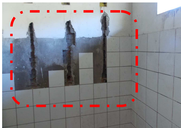
Figura 45: Aspecto geral das áreas úmidas, sendo: (a) ausência de revestimento cerâmico (a) e (b) falta a instalação de revestimento cerâmico.
