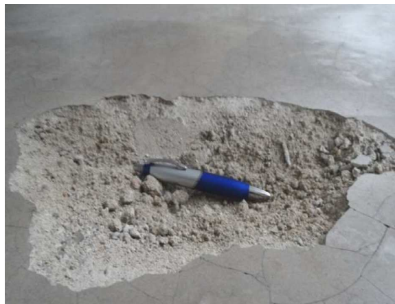
Figura 34: Fissura, trinca, buraco e argamassa pulverulenta no piso da garagem.
