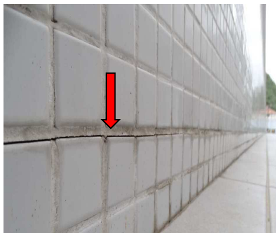
Figura 27: Abertura entre a alvenaria e o piso (a) e fissura no alinhamento do rejunte do piso cerâmico (b).
