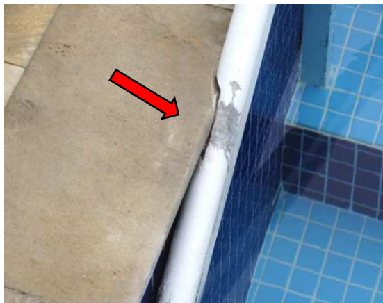
Figura 31: Corrimão obstruído e escamação da pintura (a) e (b).
