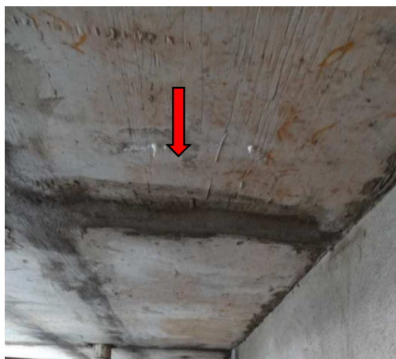
Figura 22: Destacamento e falta de aderência da manta de impermeabilização na argamassa (a), com infiltração na laje e lixiviação (b).
