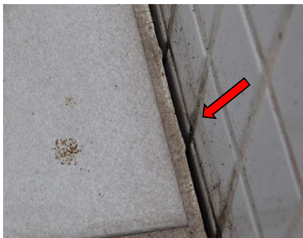
Figura 27: Abertura entre a alvenaria e o piso (a) e fissura no alinhamento do rejunte do piso cerâmico (b).
