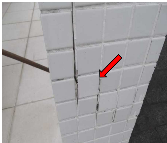
Figura 26: Trincas nas alvenarias (a) e estufamento com descolamento das pastilhas (b).
