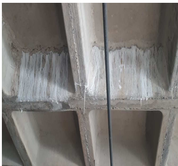
Figura 14: Lixiviação, eflorescência e formação de estalactite.
