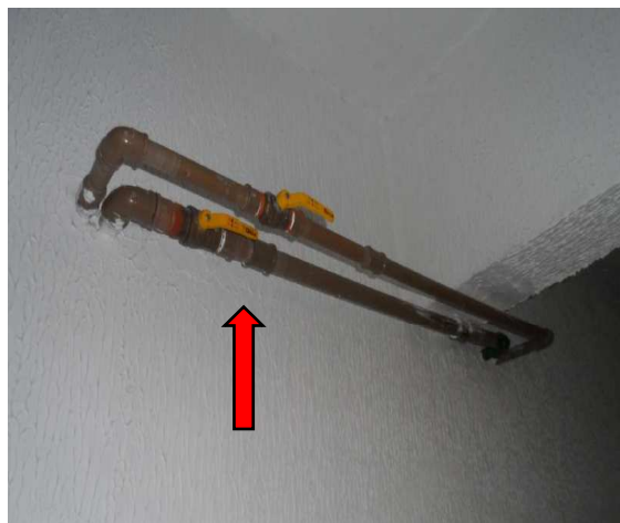
Figura 28: Ausência de suportes para fixar a caixa sifonada (a) e tubulação hidráulica sem pintura e registros sem identificação (b).
