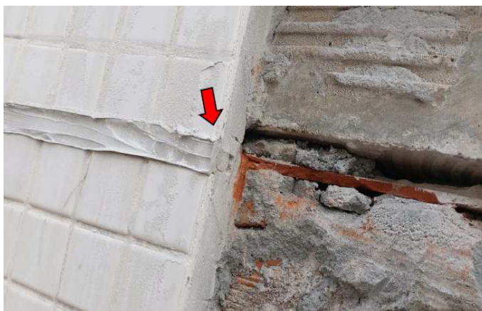
Figura 24: Detalhe da área de realização do teste de aderência. A seta vermelha indica a situação do delimitador de profundidade e do selante.
