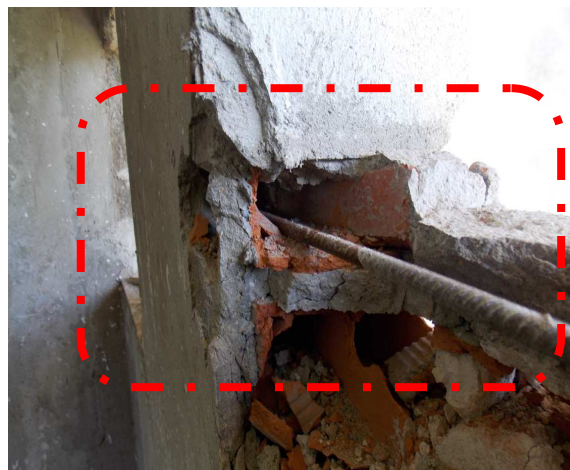
Figura 43: Contraverga não atende o requisito altura (a) e (b) a barra de aço instalada no furo do tijolo.
