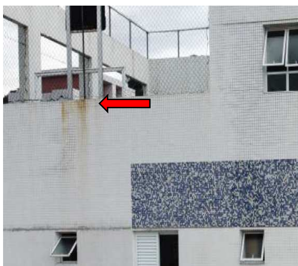
Figura 20: Manchas de escoamento de ferrugem (a) e sujeiras na fachada (b).
