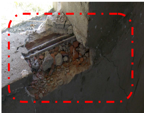
Figura 43: Contraverga não atende o requisito altura (a) e (b) a barra de aço instalada no furo do tijolo.
