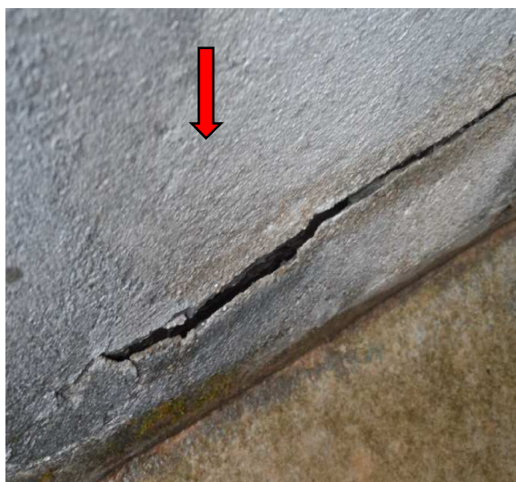
Figura 22: Destacamento e falta de aderência da manta de impermeabilização na argamassa (a), com infiltração na laje e lixiviação (b).
