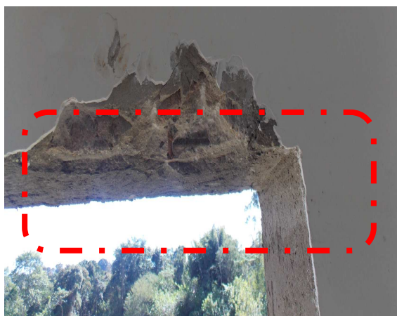
Figura 44: Armadura exposta no fundo da viga, sendo: (a) o aspecto geral da viga de concreto armado e (b) o detalhe da medição, que mostra 19mm de cobrimento no aço.
