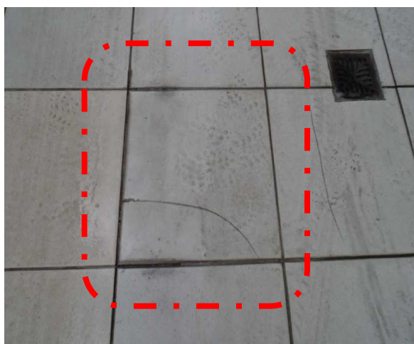
Figura 35: Não houve contato da argamassa de assentamento e o tardo, causado a quebra.
