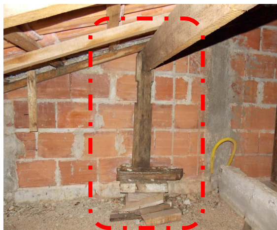
Figura 49: Ausência de emenda entre as terças (a) e pontalete com calços (cunhas) (b).
