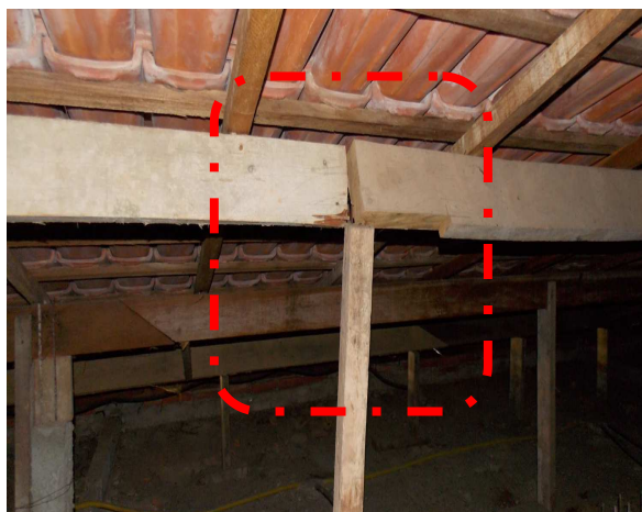
Figura 49: Ausência de emenda entre as terças (a) e pontalete com calços (cunhas) (b).
