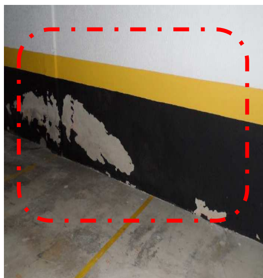
Figura 36: Umidade na alvenaria do subsolo, desgaste da pintura (a) e (b).
