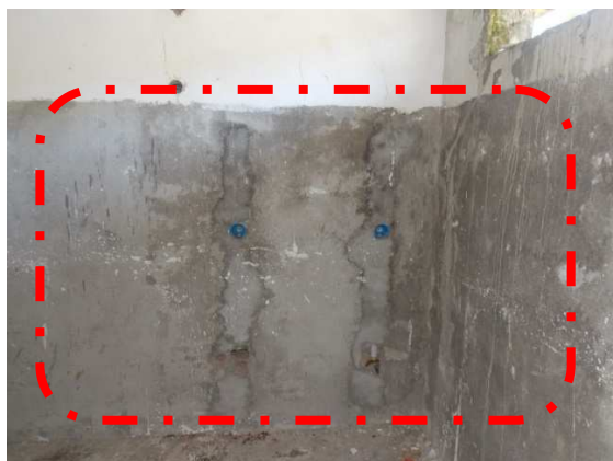
Figura 45: Aspecto geral das áreas úmidas, sendo: (a) ausência de revestimento cerâmico (a) e (b) falta a instalação de revestimento cerâmico.
