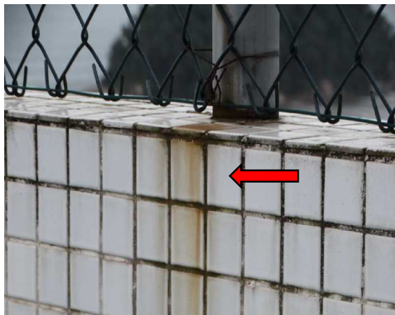
Figura 21: Revestimento com marcas de ferrugem (a) e oxidação galvânica na estrutura do alambrado (b).
