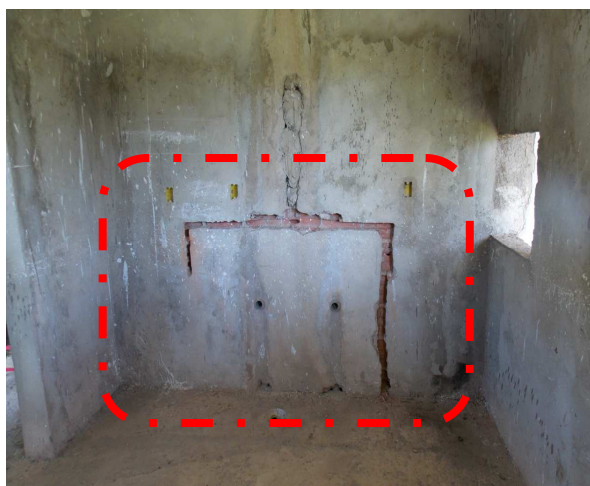
Figura 46: Ausência das instalações hidráulicas e hidrossanitárias (a) e (b).
